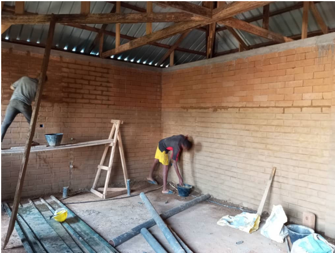
Überarbeitung der Wände im Arbeitsraum.
