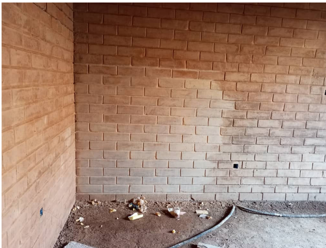
Detail der Lehm-mauer.
